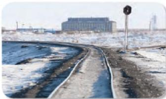
**Figura 1.13** La dilatación térmica puede deformar las vías del ferrocarril y ocasionar accidentes.
