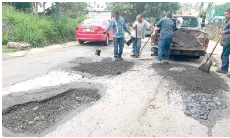
FUERON RETIRADOS CASI 100 metros cúbicos de pavimento en mal estado en calles de la colonia Universo.
