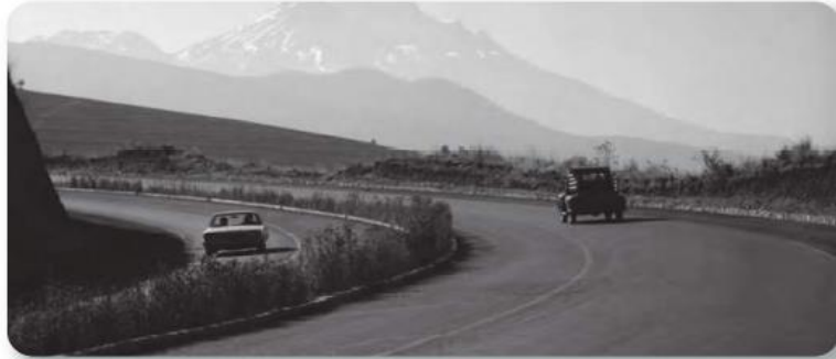
Figura 3.5 Entre 1950 y 1970, la red de carreteras nacionales se amplió de 22 mil kilómetros aproximadamente a cerca de 71 mil kilómetros. Tramo de una carretera, panorámica (ca. 1965).
