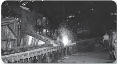
Figura 2.50 La industria siderúrgica mexicana tuvo gran importancia para la industrialización del país. Entre las más importantes estaban las que se instalaron en la Ciudad de México y en Monterrey, Nuevo León. Instalaciones interiores de la fundidora Monterrey (1940).
