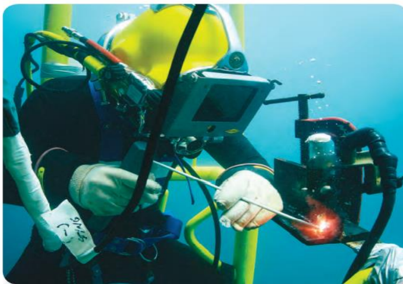
Figura 2.34 El acetileno se utiliza para soldar metales bajo el agua.
