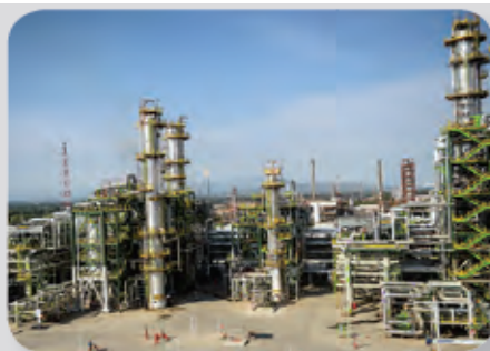
Figura 2.27 El craqueo catalítico se lleva a cabo en torres con controles electrónicos que regulan presión, temperatura, flujos y catalizadores.
