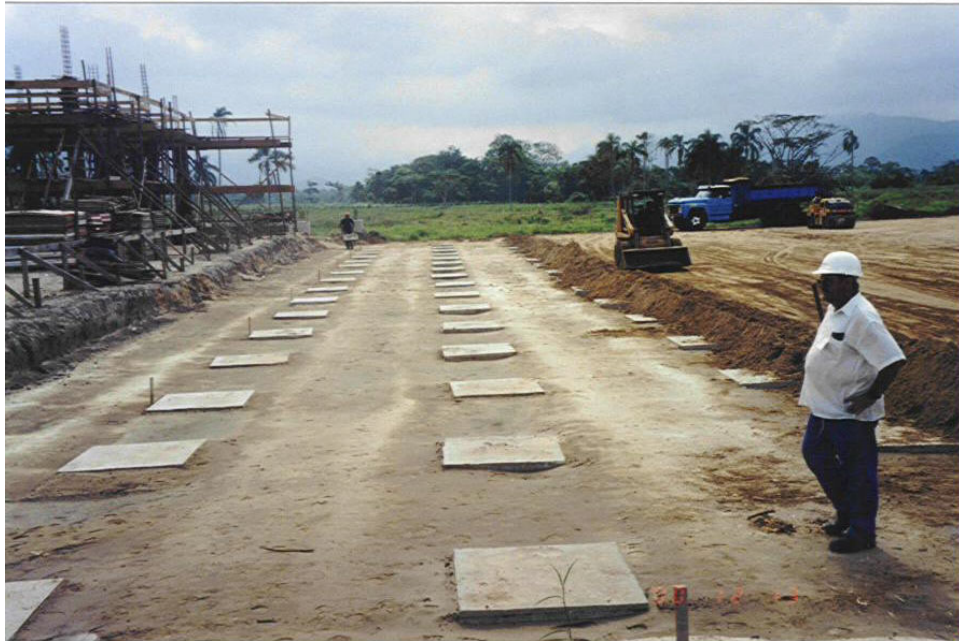
Foto 2 – Reaterro em execução sobre Capitéis.
