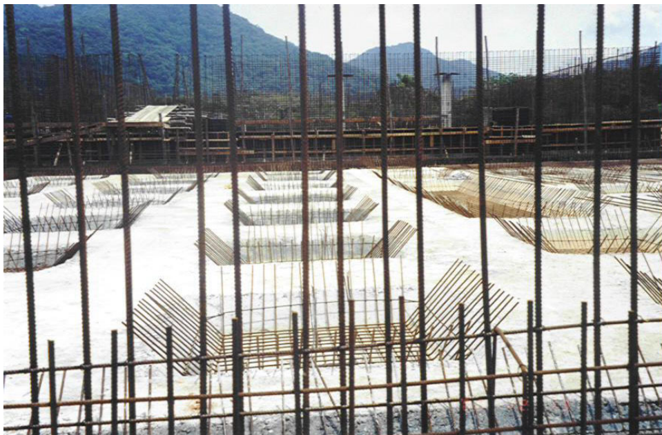
Foto 3 – Concretagem de Laje de Fundo, Mostrando engrossamento do Radier sobre os Capitéis.
