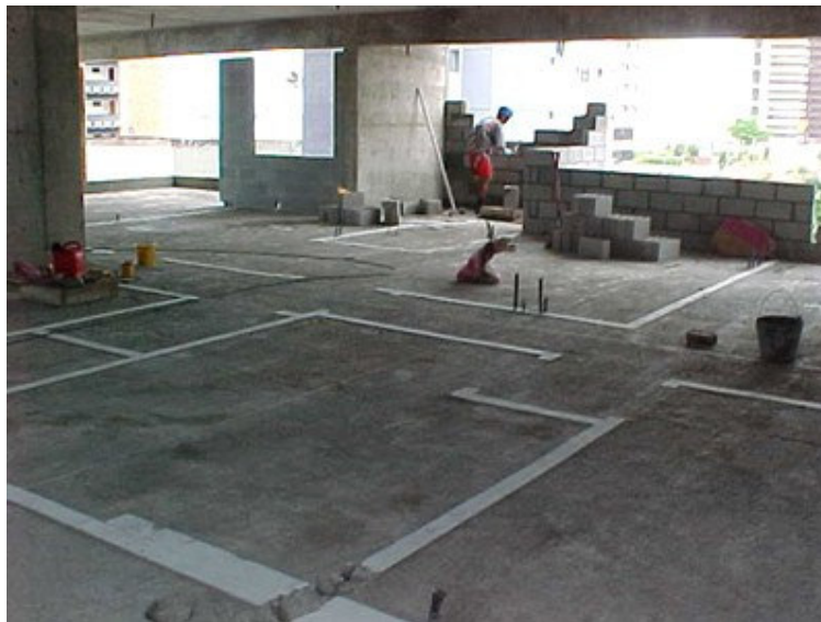
Figura 14. Marcação de parede de alvenaria no piso.
