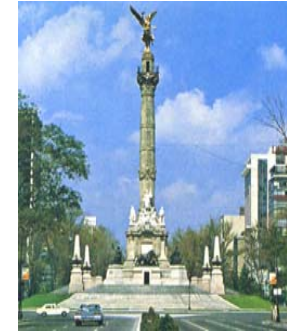
COLUMNA de la INDEPENDENCIA ; E. ALCIATI - A. RIVAS - R. GAYOL : INDEPENDENCIA , estructural y compositiva, del Monumento , respecto a su entorno, natural y urbano y a cualquier otro elemento compositivo inmediato; si bien, registra un intenso y claro concepto de INTER-DEPENDENCIA , INTEGRACIÓN o SUBORDINACIÓN , entre sus tres componentes básicos, formales y estructurales o funcionales: la Escultura , Arquitectura e Ingeniería , que lo sustentan y proyectan; Siglo XX, México.
