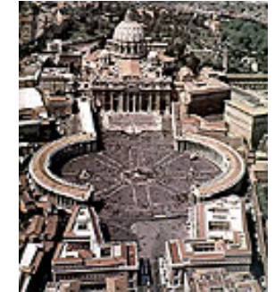
PLAZA y BASÍLICA de SAN PEDRO; BRAMANTE- BUONARROTTI-BERNINI: Dentro de los Conjuntos Urbano-Arquitectónicos, probablemente uno de los mejor INTEGRADOS , tanto en si mismo, como con referencia a su entorno inmediato y a pesar de su muy compleja evolución histórica y múltiple autoría, técnico-artística; Siglos XV a XVII, Italia.
