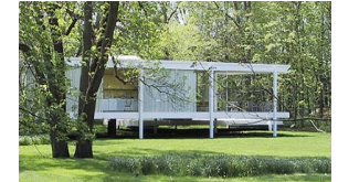
CASA "FANRNSWORTH", M. V. D. ROHE: Destacada y magistral obra de su talentoso autor alemán, sobresaliente miembro, fundador y promotor, de la Escuela FUNCIONALISTA , de la BAHAUS , promotora de las características RACIONALISTAS, INDUSTRIALES y RECTILÍNEAS , de la Época Contemporánea y en la cual se proyecta una clara TRANSPARENCIA , de sus elementos verticales y vítreos, respecto, tanto a su interior, como a su entorno circundante o FONDO, naturales y boscosos; Siglo XX, EUA.
