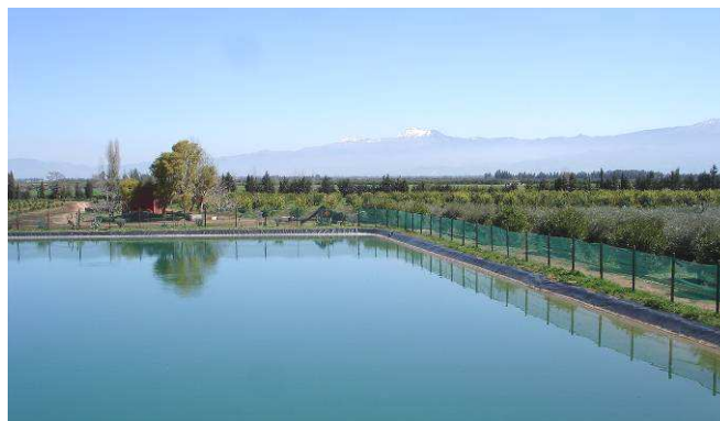
Bassin d'accumulation pour l'irrigation localisée dans une exploitation des Domaines Agricoles au Tadla
