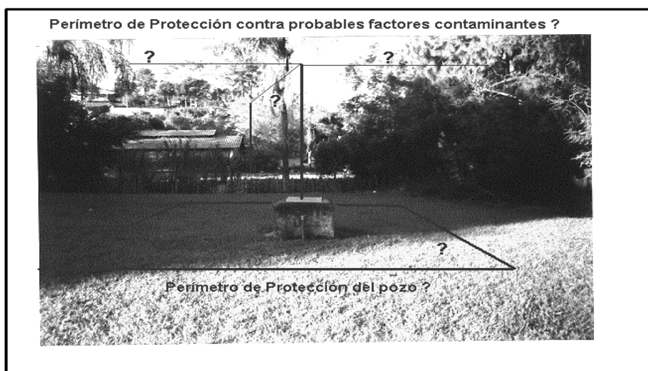
Figura 6 - Un pozo que abastece a un balneario que evidencia la cuestionabilidad de seguridad que da al recurso que ofrece. (Foto tomada por los autores en mayo de 1998)
