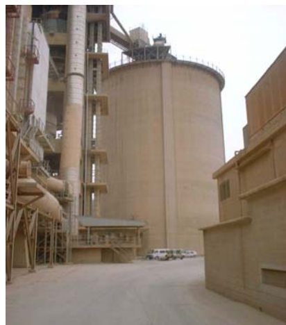
Aspecto exterior de um silo de farinha
