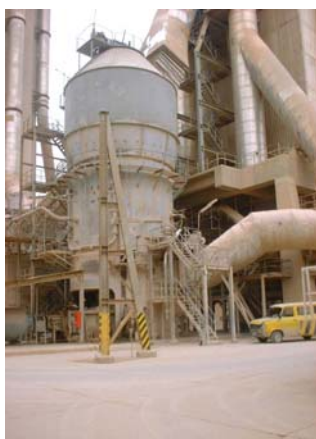
Aspecto exterior de um moinho de cru vertical
