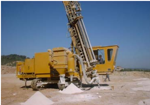
Furos de 150 mm, malha de 4 x 4 m e altura de 22 m
