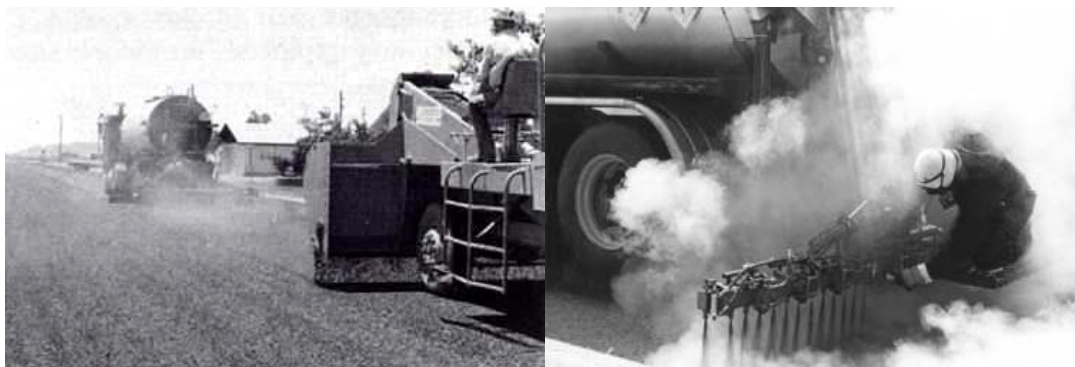
FIGURA 3.9 – Execução de um SAM (Fonte: ALL STATES ASPHALT Inc., 1999)
