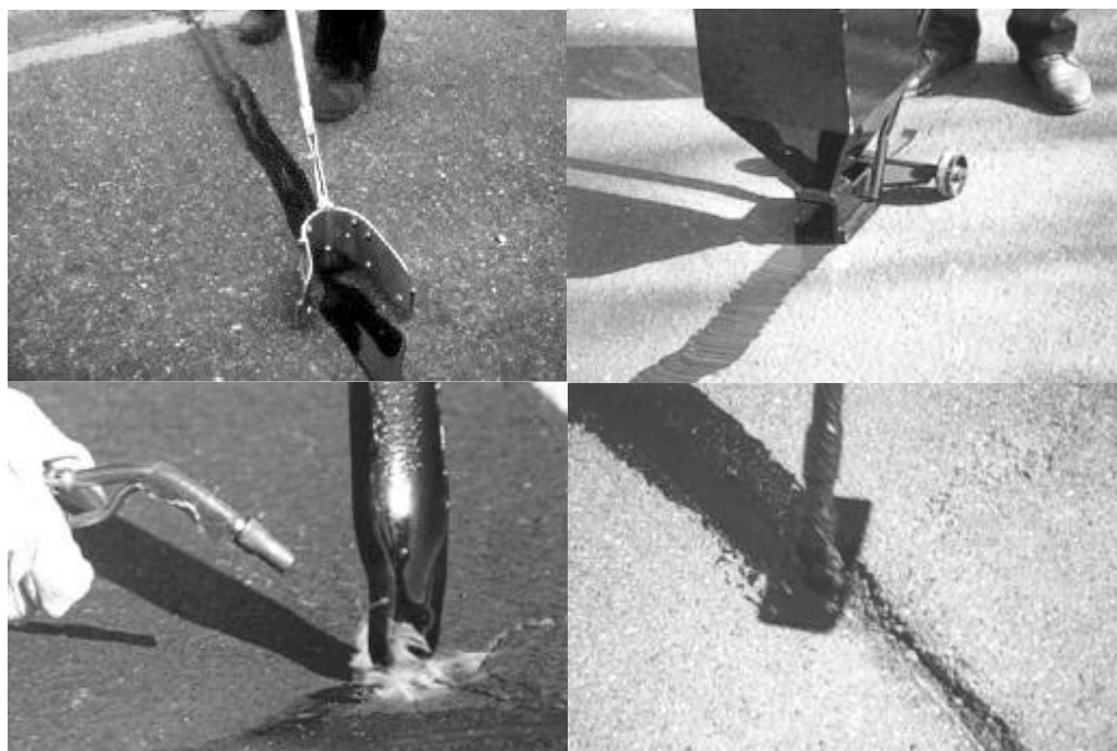
FIGURA 3.7 – Aplicador manual utilizado na selagem de trincas
