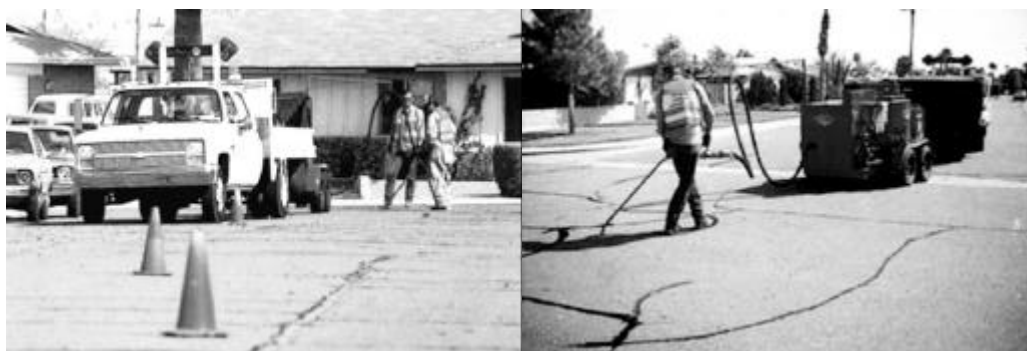
FIGURA 3.8 – Aplicação de selante de trincas no Estado do Arizona (Fonte: CRAFCO, 1980)
