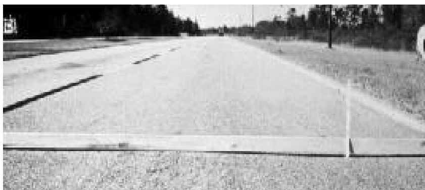
FIGURA 1.2 - Deformação permanente nas trilhas de roda (Fonte: FERNANDES, JR. et al. , 1999)
