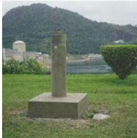
Figura 5 – Pilar com chapa de identificação fixada no sue corpo.
