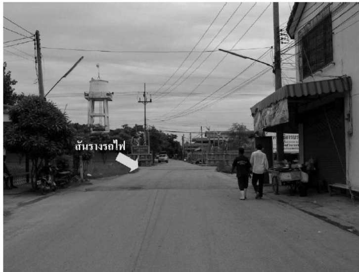
รูปที่ 5-9 ลักษณะทางลัดผ่านในปัจจุบันซึ่งไม่มีการติดตั้งเครื่องหมายจราจรทำให้ตำแหน่งของทางตัดผ่านไม่ชัดเจน รวมทั้งมีทางแยกมาเบี่ยงเบนความสนใจของผู้ขับขี่ (มุมมองจากถนนมหาชัยนิเวศน์)
