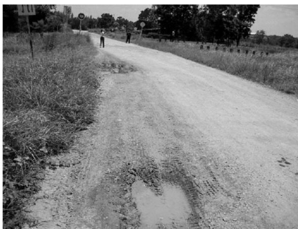
รูปที่ 5.26 ลักษณะของผิวทางที่เป็นทางลูกรัง และเป็นหลุมบ่อ
