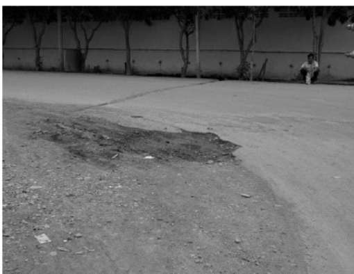
รูปที่ 5-11 สภาพผิวทาง บริเวณทางตัดผ่าน จากถนนมหาวิทยาลัยเวรด์น เข้าสู่ถนนเดิมบาง
