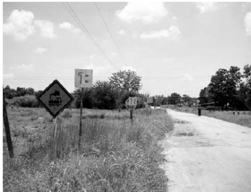
รูปที่ 5-24 ป้ายทรุดโทรมที่บริเวณทางตัดผ่าน
