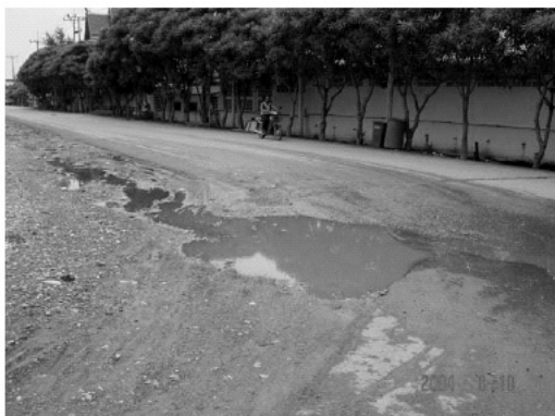
รูปที่ 5-12 สภาพผิวทาง บริเวณทางตัดผ่านในรูปที่ 5-10 หลังจากฝนตก
