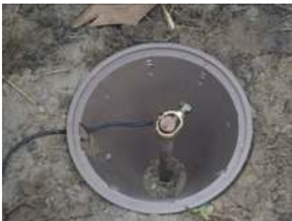
Ilustração 18 - Caixa de inspeção
