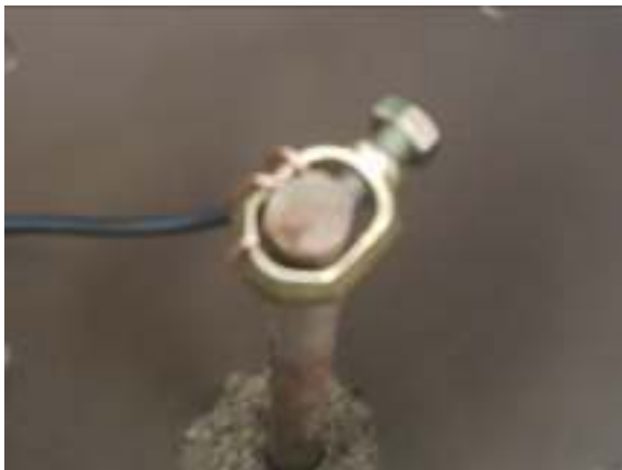
Ilustração 17 - Fio conectado a haste
