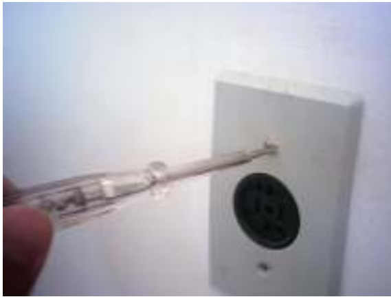
Ilustração 6 - Retirando o espelho
