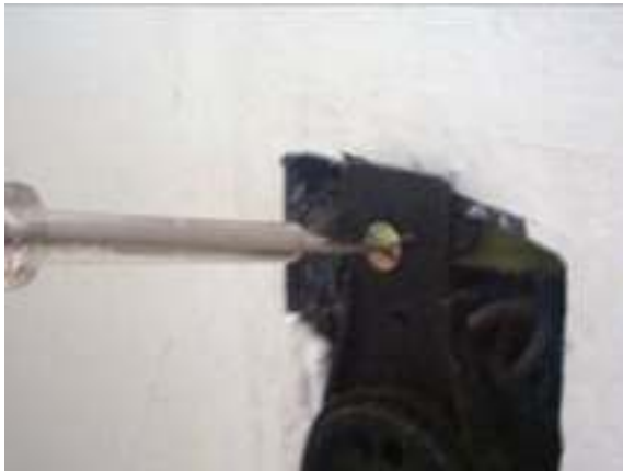
Ilustração 7 - Retirando a tomada
