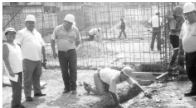
Supervisan los trabajos: Betty Fernández, Secretaria del Comité de Obras, José Ojeda, Presidente del C.A., Carlos Castillo y Tarcilo Castro, Administrador.
