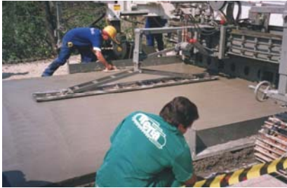
PAVIMENTADORA COM FORMAS DESLIZANTES
