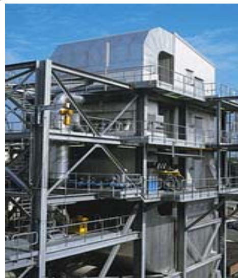
Figuras 2.2 e 2.3. Equipamentos para remoção de SO 2 e NO x . (SEGHERS, 2002). À esquerda (Fig.2.2), atomizador (tecnologia rotacional) de solução de cal para a remoção de SO 2 e resfriamento dos gases. À direita (Fig.2.3), redutor seletivo catalítico (SCR) para NO x , através de reações termoquímicas, com injeção de amônia (NH 3 ) ou uréia (CO(NH 2 ) 2 ) nos gases, em presença de um catalisador.
