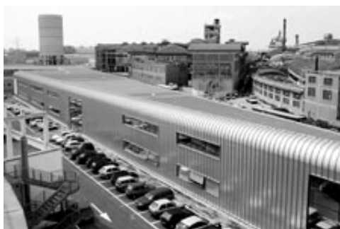
Un bâtiment du Parc scientifique et technologique Vega à Marghera
