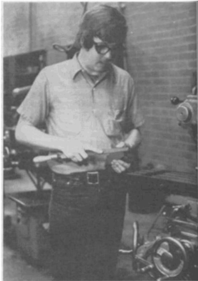
FIGURA 6. Antes de efectuar un corte con una máquina debe realizarse una prueba de la lima para determinar la maquinabilidad de una pieza (Lane Community College).
