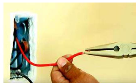
8.- Prepara las puntas del cable para su conexión al apagador inteligente
