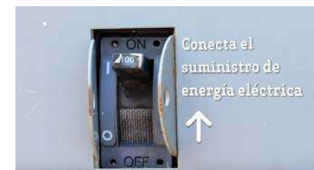
12.- Sube el interruptor a "ON" ahora requieres configurar el apagador inteligente
