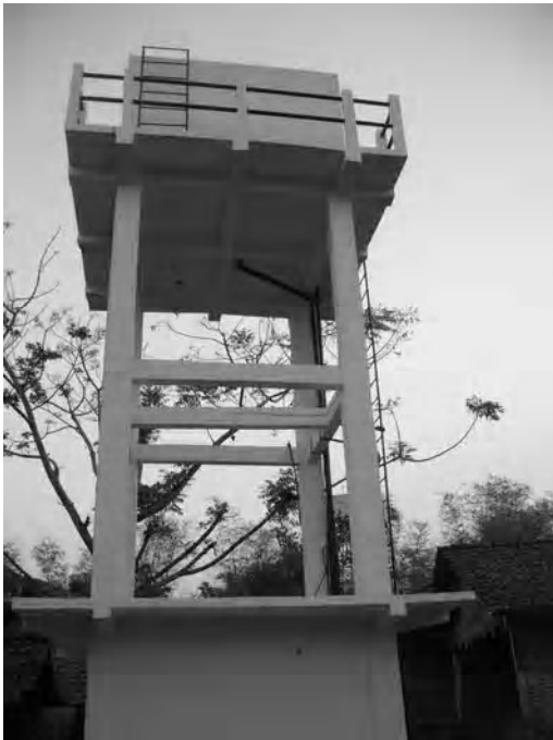
Gambar 2. Menara air di Desa Kebonagung
