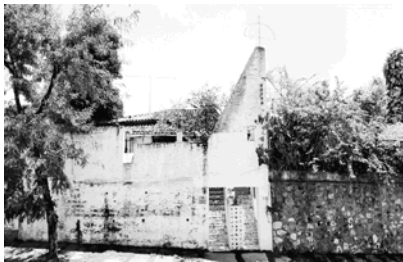
fachada da rua Alagoinhas
