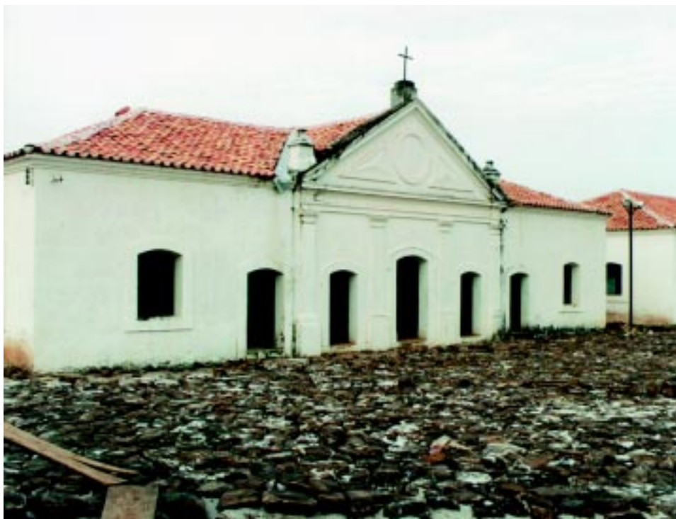
capela do forte de São José de Macapá
