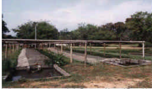
Biodigestores continuos de la Reserva Natural Pozo Verde
