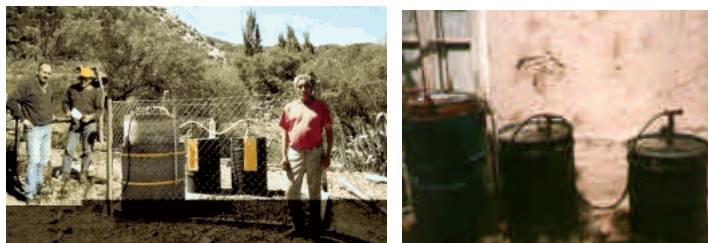
Fotografía de un biodigestor en funcionamiento.
