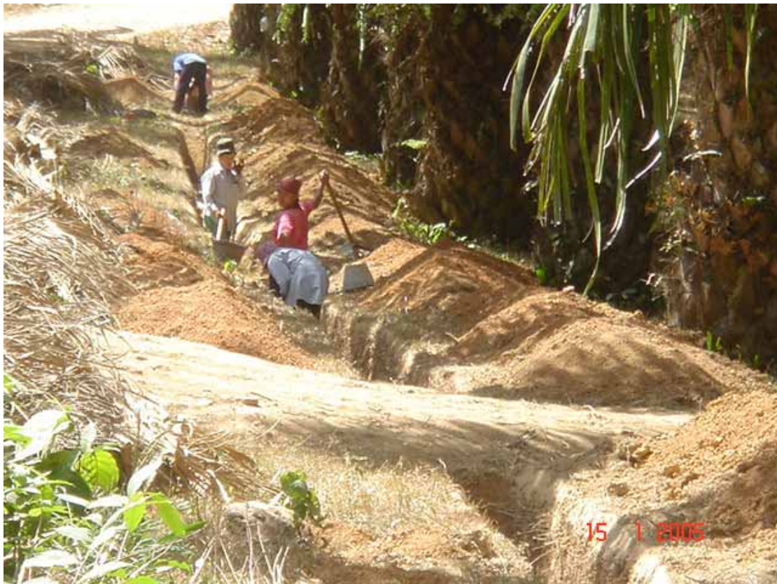
ภาพที่ 25 การขุดวางแนวท่อจ่ายน้ำเข้าสู่ชุมชนพื้นที่
