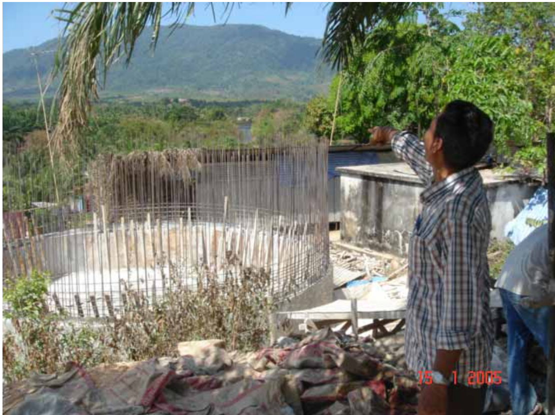
ภาพที่ 24 จุดสูบน้ำและถังจ่ายน้ำประปาจากแหล่งน้ำดิบคลองกะเปอร์ที่ใกล้เสร็จ
