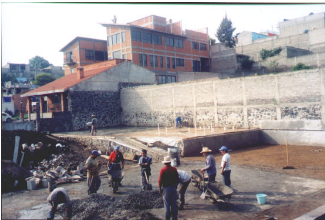
Lavori di preparazione per la base del Centro di Riabilitazione
