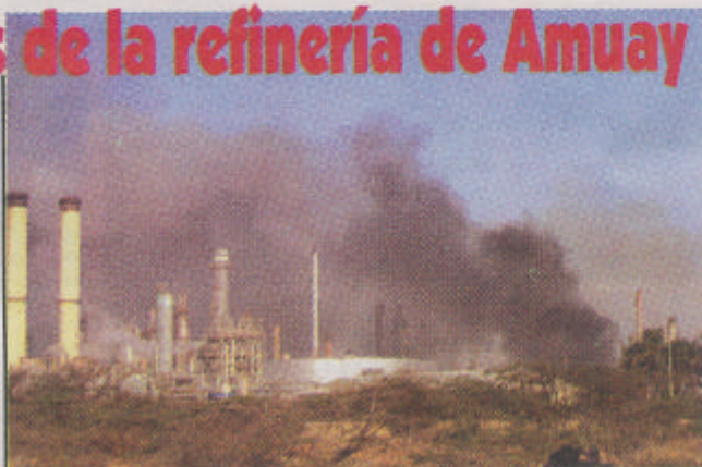
La explosión ocurrió en la subestación eléctrica del Bloque 25, específicamente en la Barra Sincrónica No. 4. Digifoto: Carlos Díaz
