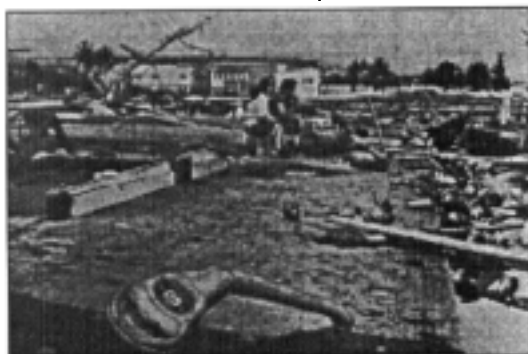
Tiang dan meteran parkir yang bengkok merupakan akibat gelombang tsunami yang terjadi pada bulan Mei 22, 1960 di Hilo, Hawaii.
