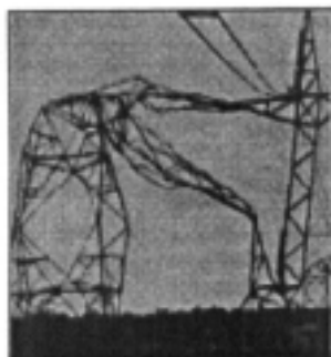
Jaringan listrik yang roboh antara Afrika Selatan dan Maputo setelah terjadi badai siklon Maret 26, 1985. UNDRO NEWS, maret/ April 1985
