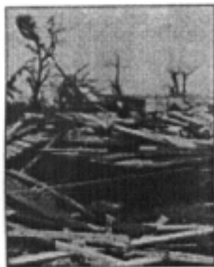
Kerusakan hurricane di Nikaragua, 1988. UNDRO NEWS, Mei/ Juni 1989
