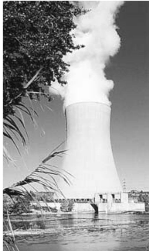
Figura 5. Torre de refrigeración de tiro natural
