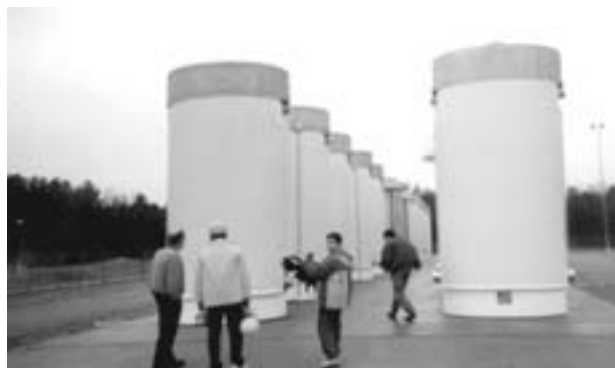
Figura 6. Almacén Temporal en Seco de combustible gastado (Surry – EE.UU.)
