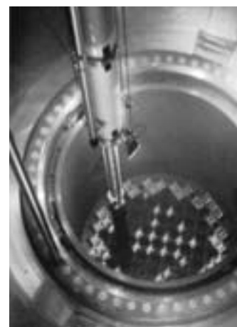
Figura 1. Carga del combustible del núcleo de un reactor nuclear
