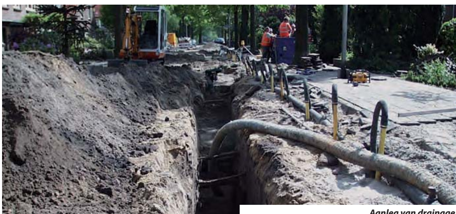
Aanleg van drainage.
