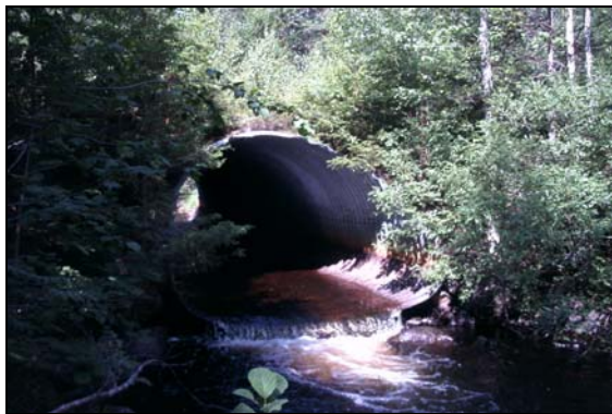
Foto 7.2.3. Vandringshinder 5. Halvtrumma med mindre fall i utlopp. Fallhöjd ca 0,2 m. Inv. sträcka 23, 02-07-18.
