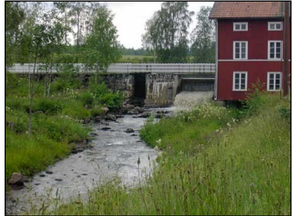
Foto 7.2.4. Vandringshinder 7. Större betongdamm. Fallhöjd ca 4,5 m. Inv. sträcka 49, 02-07-09.
