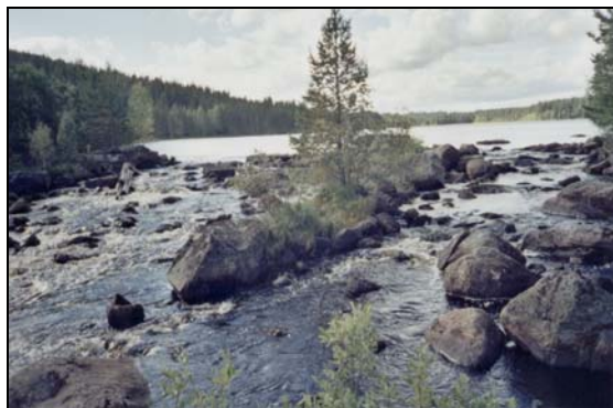
Foto 7.1.6. Vandringshinder 4. Rest av damm i Hedsjöns utlopp. Hindret redan åtgärdat. Inv. sträcka 35, 00-06-07.
