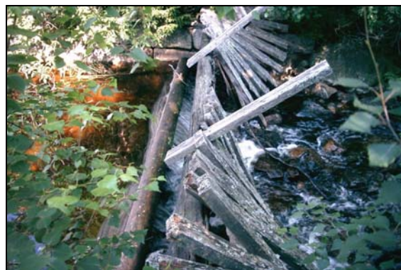
Foto 7.2.2. Vandringshinder 1. Mindre trädamms vid Mosjöns utlopp. Fallhöjd ca 0,4 m. Inv. sträcka 1, 02-07-16.
