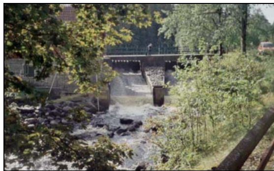
Foto 7.1.8. Vandringshinder 6. Betongdamm vid Smedjan i Åmot. Fallhöjd ca 4 m. Inv. sträcka 44, 00-09-08.
