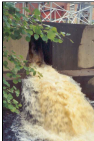
Foto 6.1.5. Betongdamm vid industri i Lingbo. Vandringshinder 7, Inv. sträcka 30, 00-08-31.
