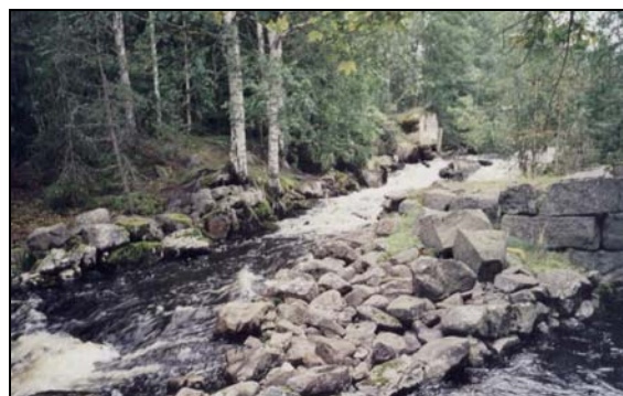
Foto 1. Vandringshinder 1. Tröskel uppbyggd av block vid Hemsjöns utlopp, fallhöjd ca 1 m. Inv. sträcka 41, 00-08-22.
