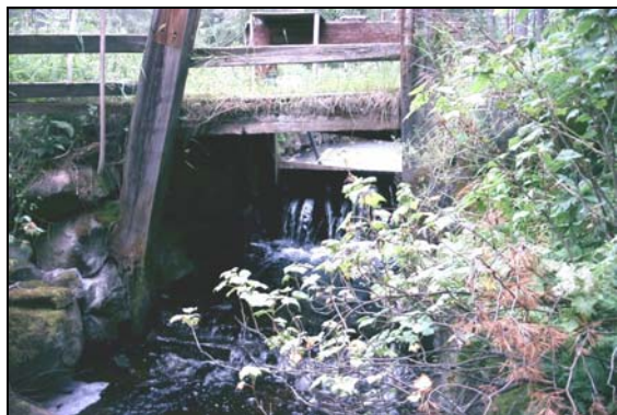
Foto 7.3.2. Vandringshinder 5. Mindre trädam. Fallhöjd totalt ca 0,6 m. Inv. sträcka 11, 02-07-18.
