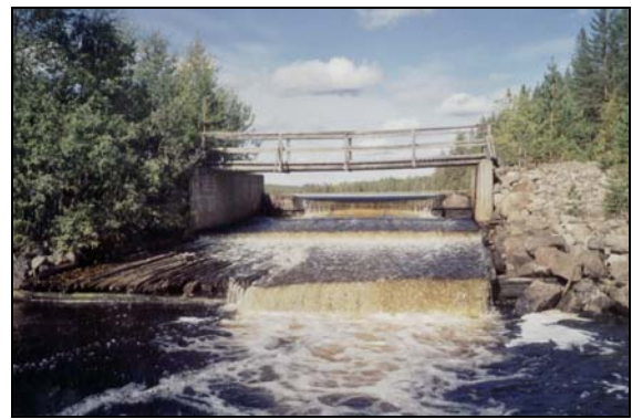
Foto 7.1.4. Vandringshinder 3. Fördämning med skibord under bro. Fallhöjd ca 1,7 m. Inv. sträcka 28, 00-09-06.
