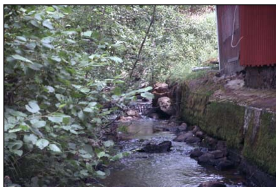
Foto 7.3.5. Vandringshinder 8. Mindre betongdam, ett av flera små, närliggande vandringshinder. Fallhöjd ca 0,3 m. Inv. sträcka 19, 02-07-09.
