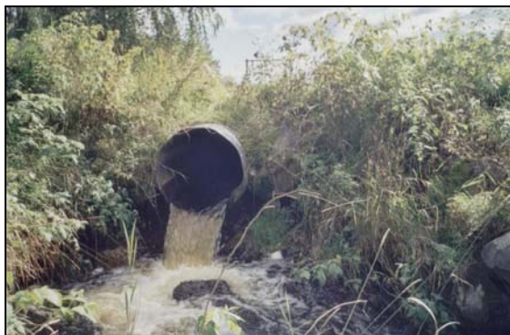
Foto 1. Vandringshinder 1. För högt satt vägtrumma, fallhöjd i utlopp ca 0,7 m. Inv. sträcka 4, 00-09-04.
