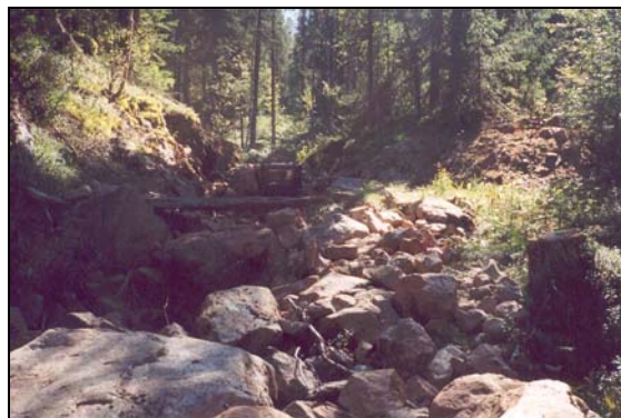
Foto 6b. Fiskvägen vid vandringshinder 6. Omlöpsdelen i förgrunden, rännans utlopp kan anas i mitten av bilden. Hela fiskvägen torrlagd. 2002-08-19.
