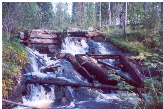
Foto 5. Vandringshinder 5. Rest av flottningsdamm liggande ovanför naturligt fall, total fallhöjd 2,5 m, 2002-08-19.
