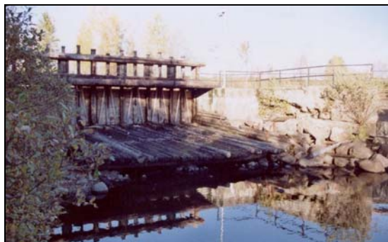
Foto 1. Vandringshinder 1. Dammluckor med skibord, Vadedammen. Inventeringssträcka 5, 03-09-21.
