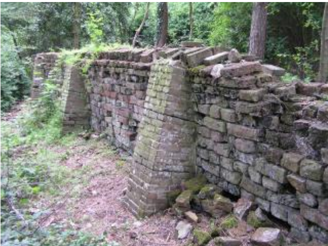
Afbeelding 14 De ringmuur met afwisselend een koppen- en strekkenlaag en de steunberen in 2008. Foto: Jaap van Rossum
