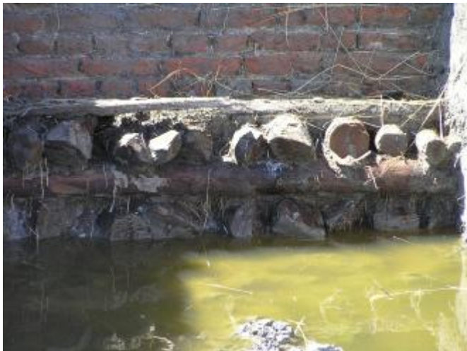
Afbeelding 1 Houten fundering onder een van de kasteelmuren van Nuwendoorn
