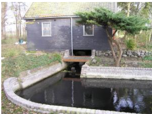
De inlaat van het gemaal; achter het loopbruggetje bevindt zich de vijzel. Op de voorgrond de door de vorige eigenaar van het gemaal aangelegde "vijver".
