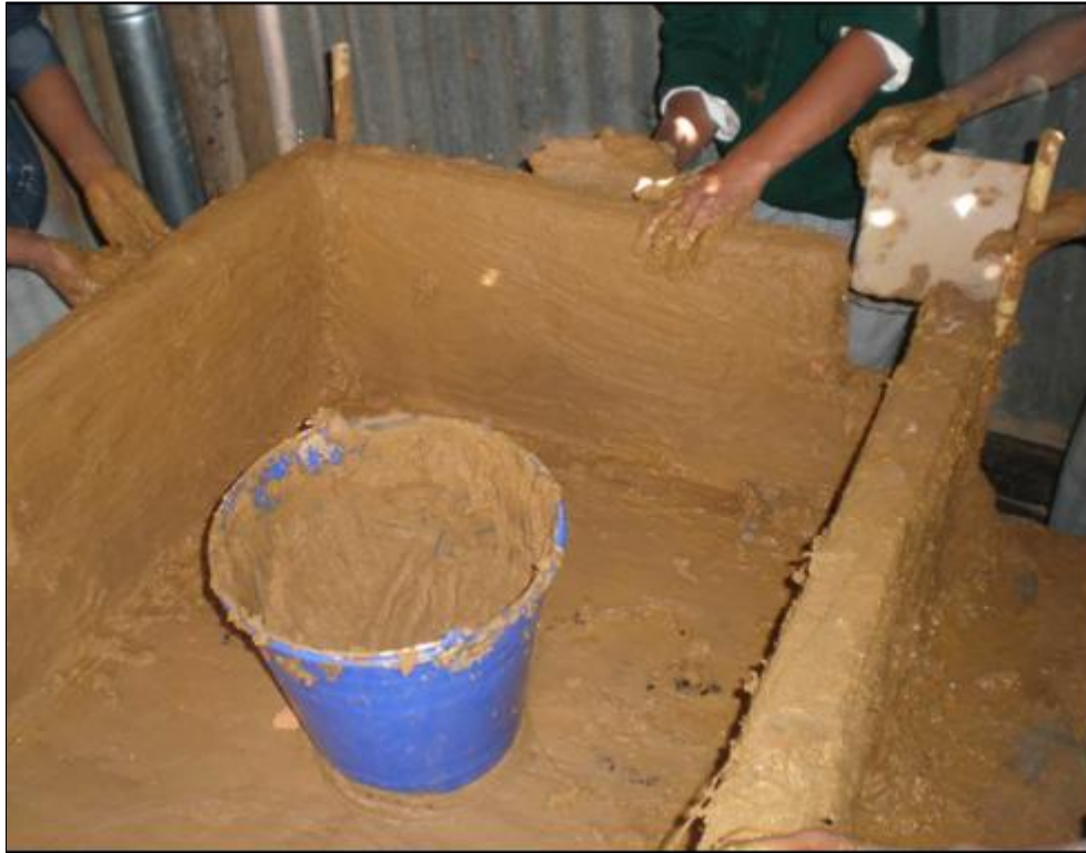
Figura 31: Segundo nivel de la estructura y último, pues dos ladrillos hacen unos 30 cm.
