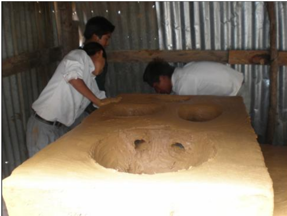
Figura 40: Más mezcla de adobe para seguir puliendo.
