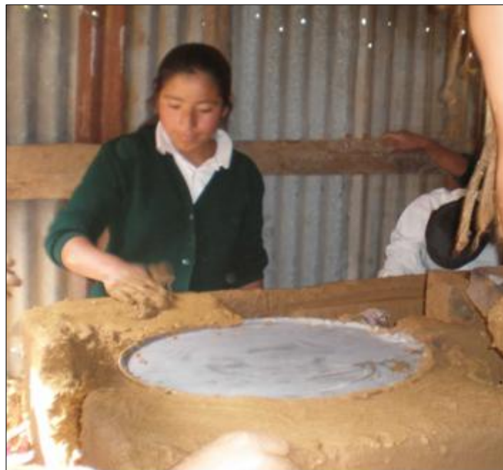
Figura 36: Construyendo la estructura del comal.
