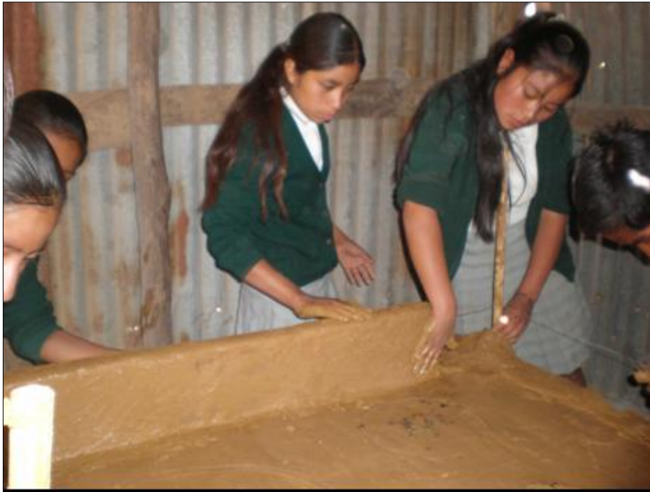
Figura 27: Primer nivel de la que será la estructura exterior de la cocina.
