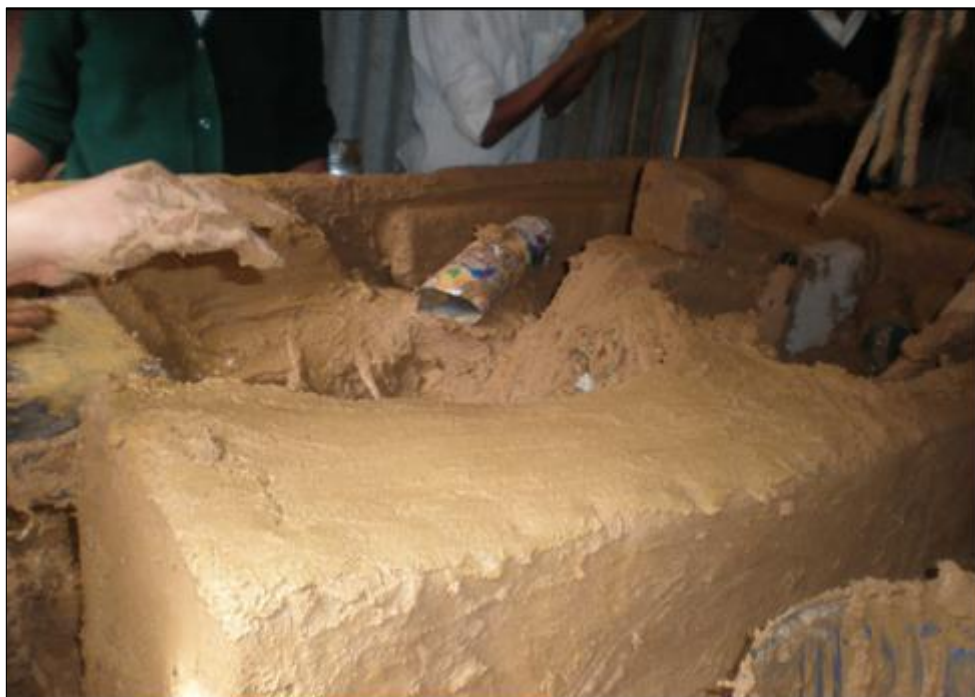
Figura 34: Moldeando los túneles y el agujero para el comal
