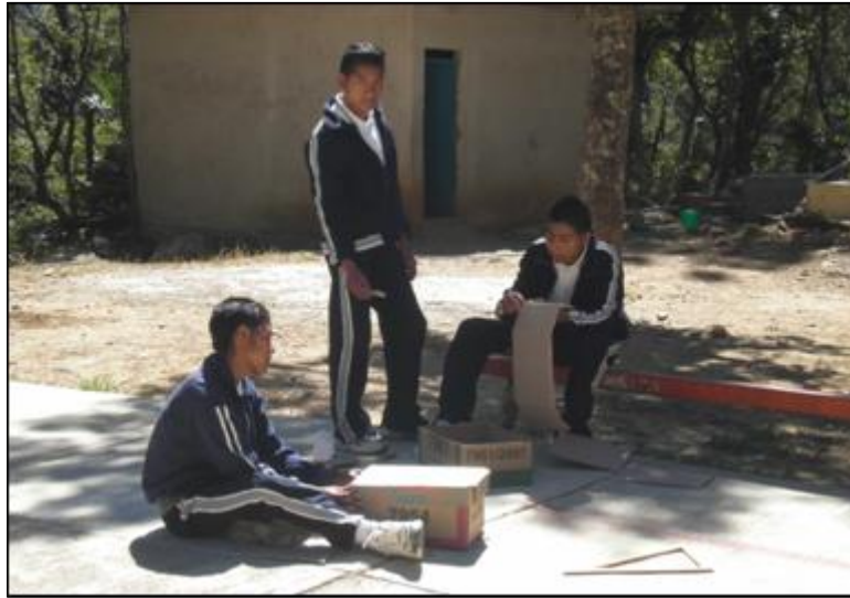
Figura 9: Alumnos construyendo el horno solar
