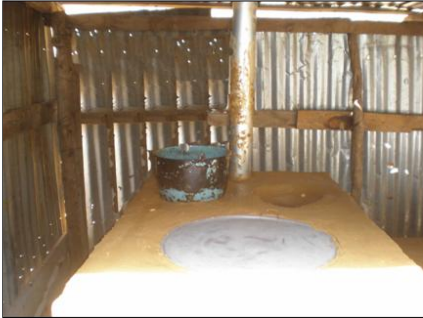
Figura 43: Cocina ahorradora de leña construida por los alumnos de Telesecundaria El Carrizal.
