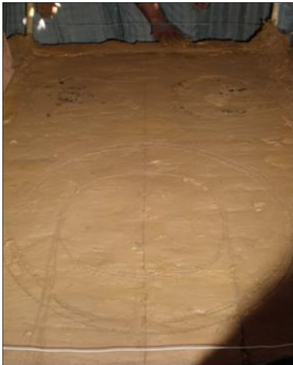
Figura 26: Esbozo de los elementos y medidas que nos guiarán durante la construcción.
