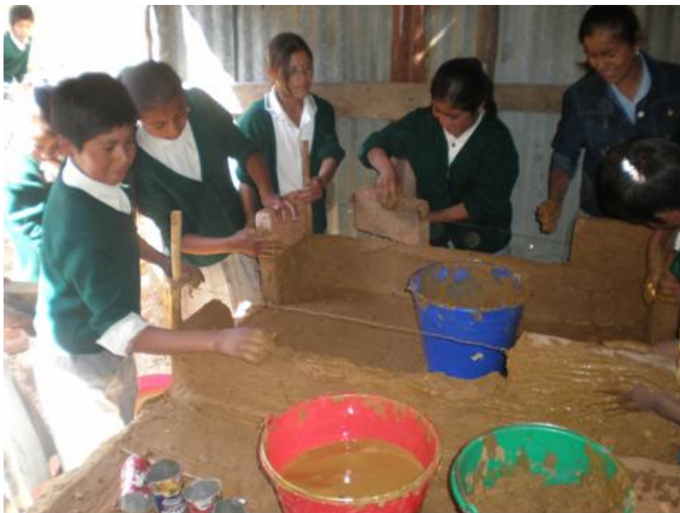
Figura 28: Construyendo el segundo nivel.
