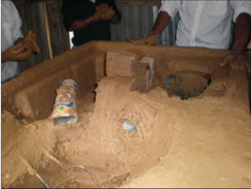
Figura 35: Construyendo el interior de la cocina.
