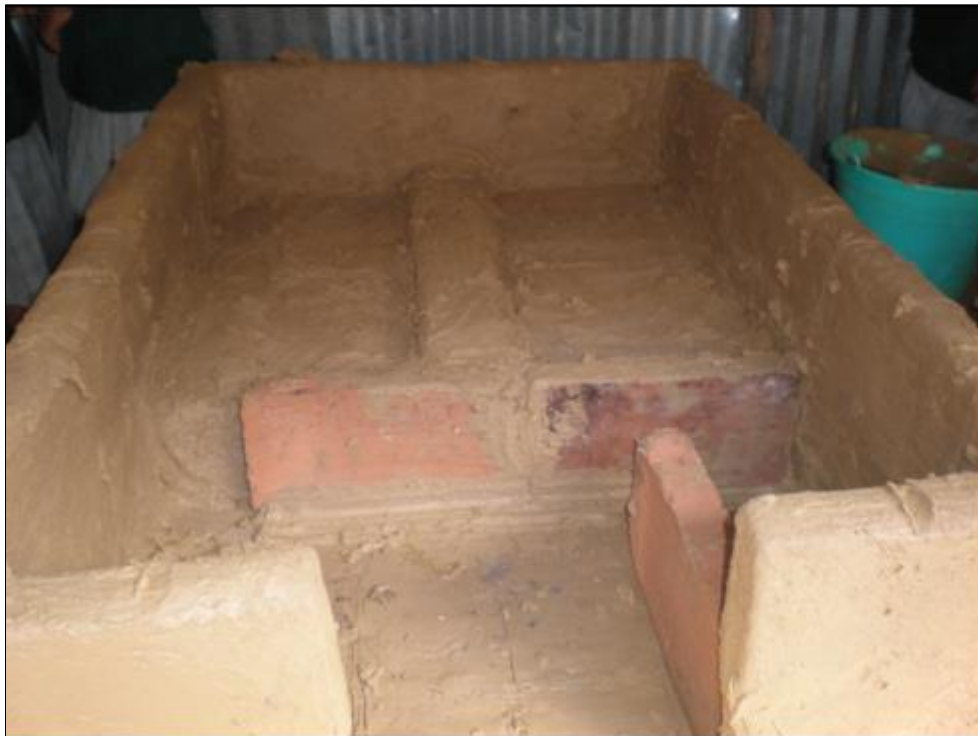
Figura 32: Estructura interior de la cocina mientras se construía la cocina.
