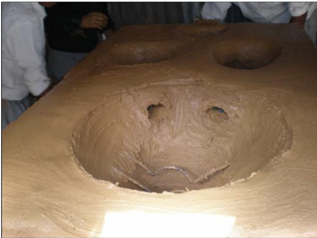
Figura 38: Detalle interior del comal y los túneles hacia las hornillas, aún sin pulir pero teniendo ya su forma.
