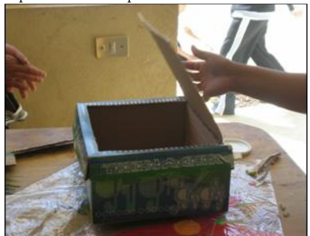
Figura 11: Horno solar con la ventana ya cortada.
