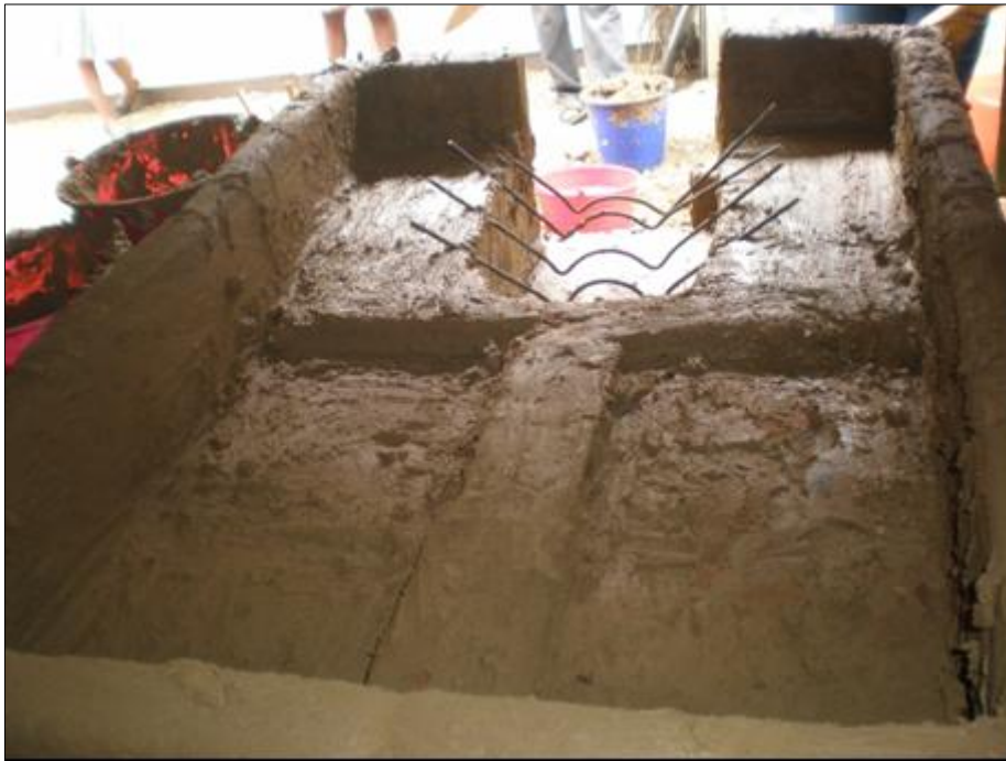
Figura 33: Relleno interior de la cocina, con las varillas para la leña (vista posterior).
