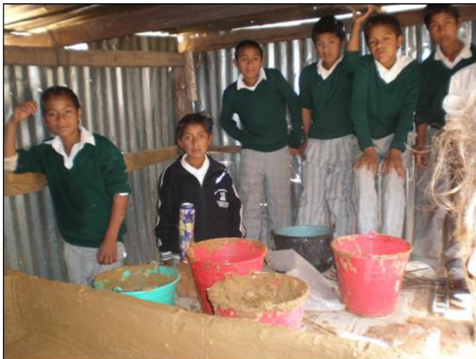
Figura 29: Alumnos mirando como se iba construyendo la cocina.
