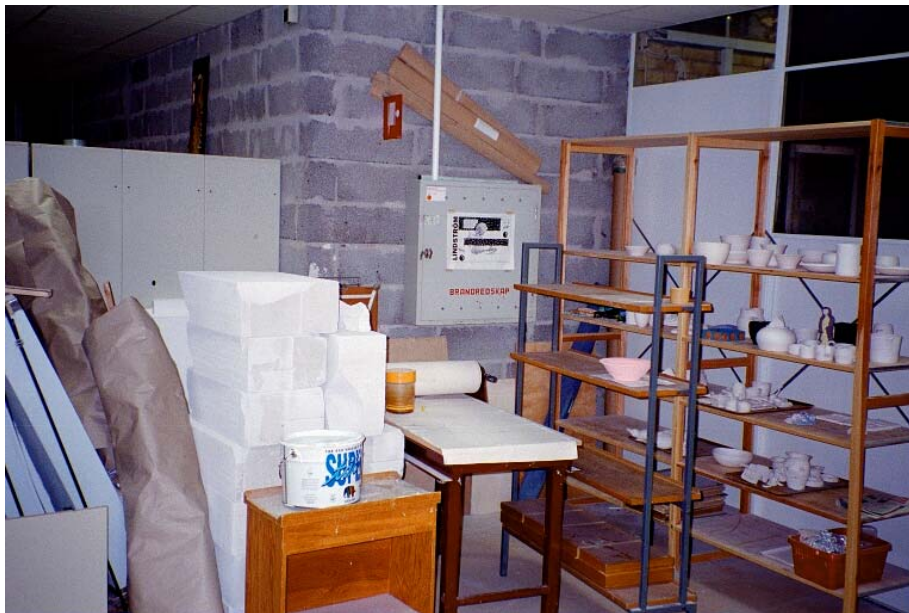
Bild 2, blockering av brandpost i plan 0
