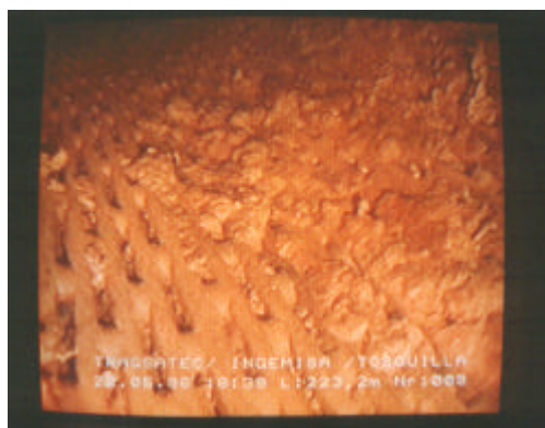
Figura 5.- Procesos de colmatación por generación de procesos incrustantes en tubería filtrante de tipo puentecillo, bien atribuible a variaciones del pH y al funcionamiento normal del sondeo.
