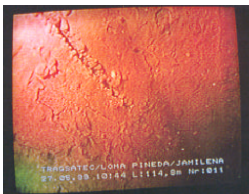
Figura 4.- Pozo rojo. Filtro ranurado. Chorreras ferruginosas. Costras fracturadas.
