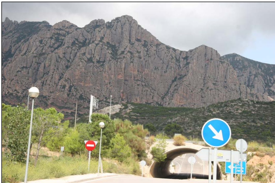
↑ Túnel d'accés al polígon industrial Les Ginesteres.
