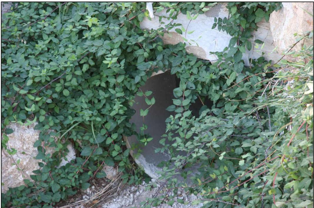
↑ Obra de drenatge de 80cm de diàmetre a La Fumada, Collbató.
