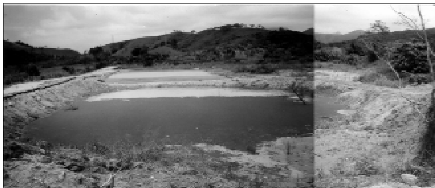
Figura 1: Vista geral do entorno dos lagos, situação atual.
