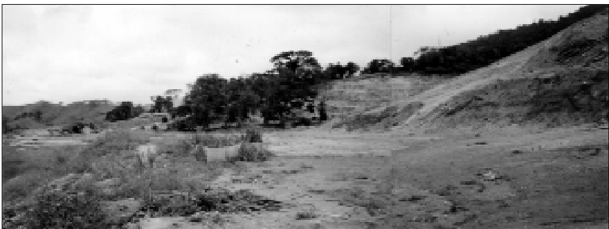
Figura 4: Vista lateral de acesso ao Aterro Sanitário
