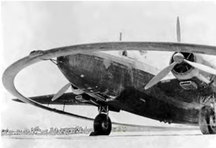
Figura 6.8. El avión AF Vickers Wellington DWI Mark II de la Royal Air Force fue otra respuesta para neutralizar las minas magnéticas alemanas. El anillo de madera de balsa, de 4 m de diámetro, creaba un campo magnético mediante una bobina de aluminio alimentada por un generador dentro del avión. Al volar rasante sobre el agua hacía estallar las minas.
