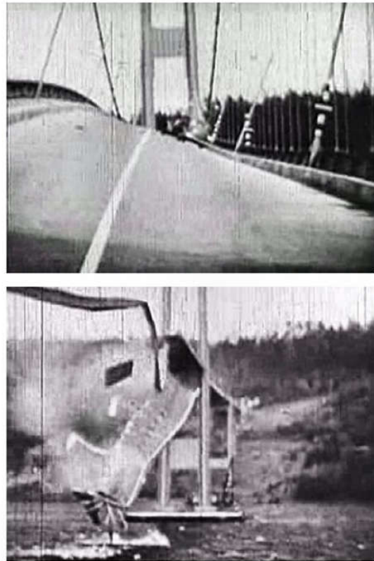
Figura 8.16. Destrucción del puente de Tacoma Narrows en 1940.
