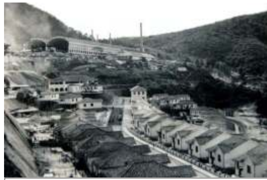
Vista parcial da usina e de construções diversas, escola, posto médico, comércio, hotel e moradias para os operários, etc.
