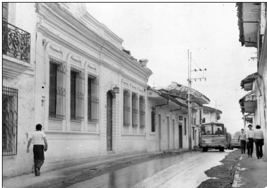
Casa de la familia Orozco Aristizábal, identificada con el nro. 4-56 de la carrera 9ª de Popayán; derruida en el terremoto del 31 de marzo de 1983, quedando en pie solamente su fachada, tal como la muestra la fotografía de junio de 1983.
