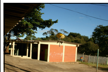
Pátio da escola - vista dos fundos
